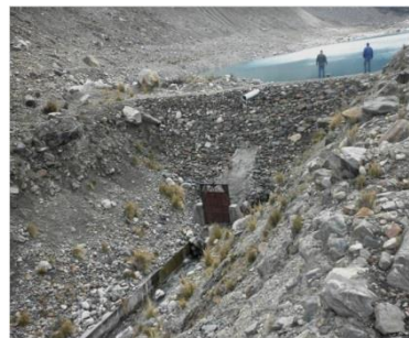
Compuerta y canal de salida de la laguna
