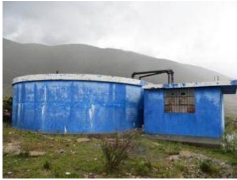
Reservorio apoyado de Viques
