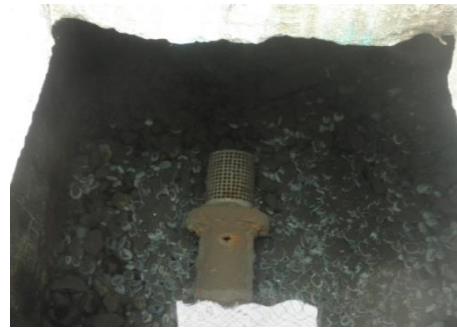
Interior de la Caja de Captación
