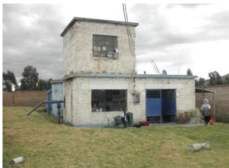
Estación de Bombeo ORCOTUNA
