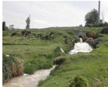
Descarga de Desagüe Jr. Lima al cauce del Río
