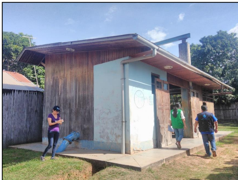
Imagen N° 15: Pozo Palmeras II
