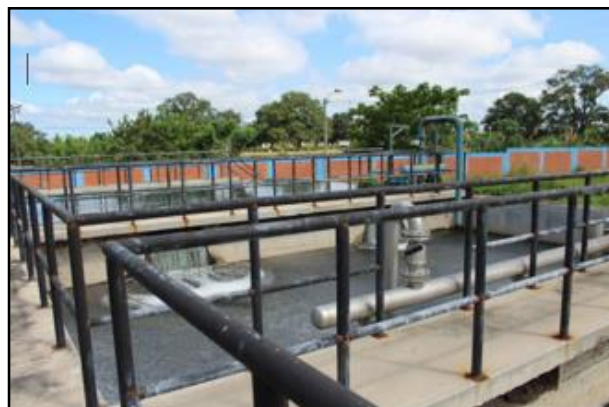
Imagen N° 45: PTAR N° 03 Lodos Activados
