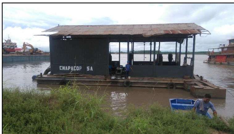
Imagen N° 3: Balsa de Captación
