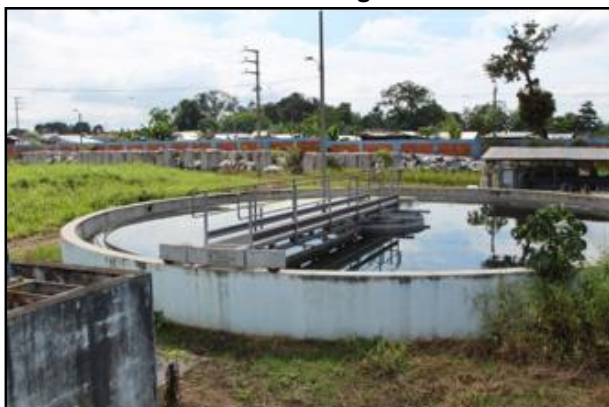
Imagen N° 45: PTAR N° 03 Lodos Activados
