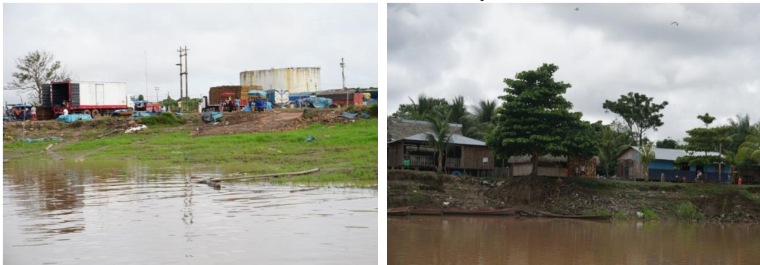
Imagen N° 58: Quebrada Yumantay afectada por aguas residuales y botaderos de residuos sólidos en el cauce el río Abujao
