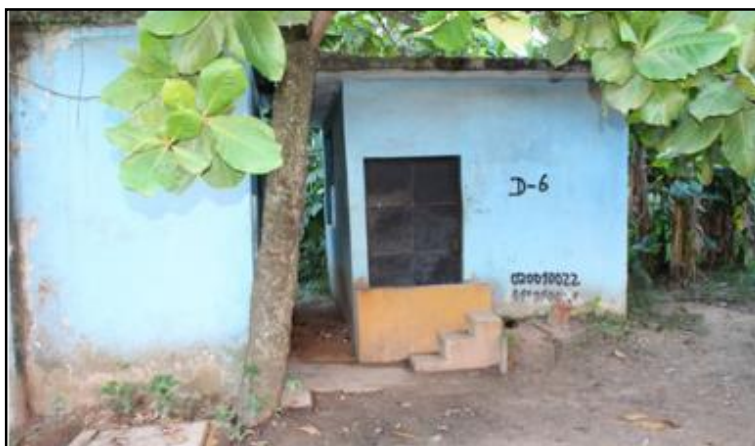
Imagen N° 32: Cámara de Bombeo de Desagüe D-6
