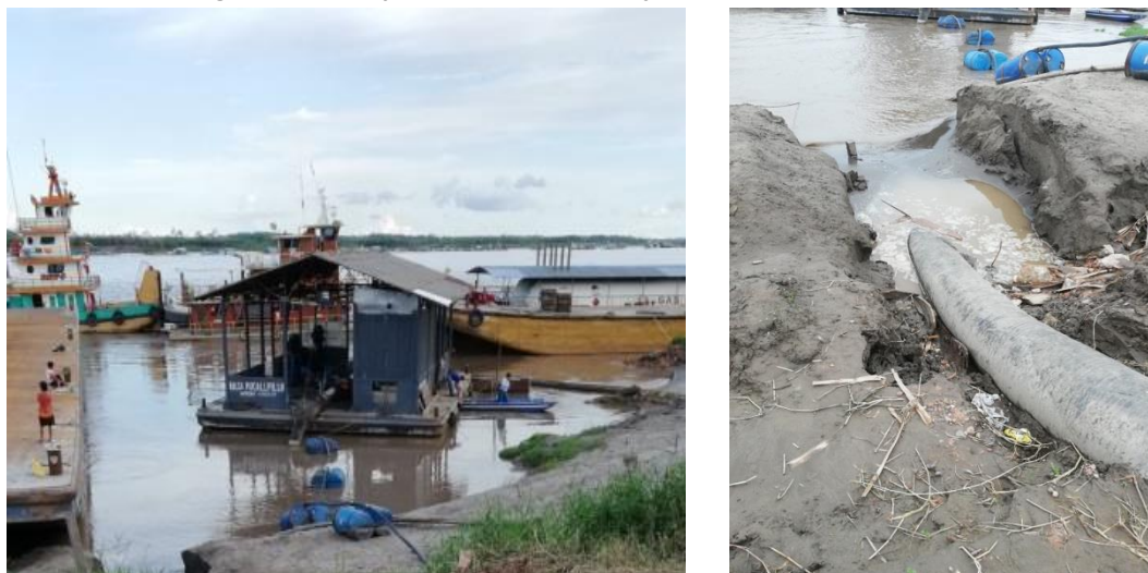
Imagen N° 49: Captación de fuente superficial Balsa flotante
