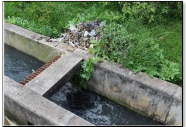
Imagen N° 36: Cámara de llegada a la PTAR de Lagunas
