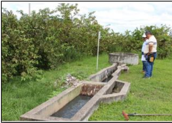
Imagen N° 36: Cámara de llegada a la PTAR de Lagunas
