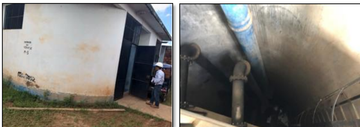
Imagen N° 33: Cámara de Bombeo de Desagüe M-3
